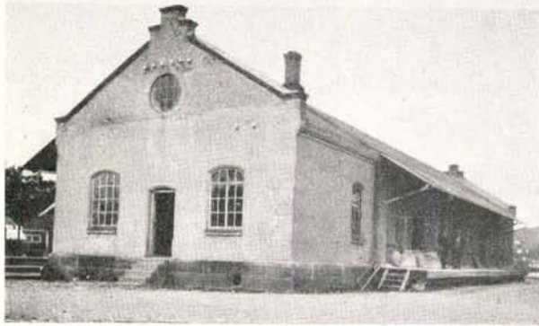
Sandnes nye stasjonsbygning og nye godshus.
